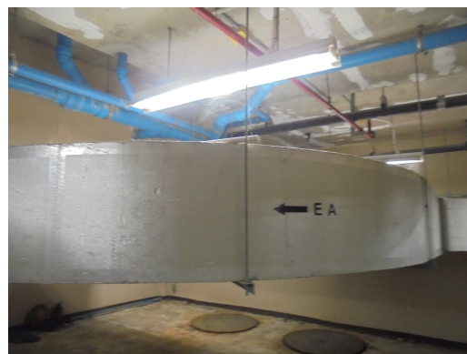
ภาพที่ 3-9 ท่อระบายอากาศที่ระบบบำบัดน้ำเสีย มีระบายอากาศดีเข้าและระบายอากาศออก
