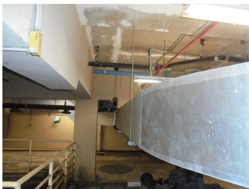
ภาพที่ 3-9 ท่อระบายอากาศที่ระบบบำบัดน้ำเสีย มีระบายอากาศดีเข้าและระบายอากาศออก
