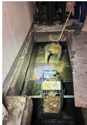
ภาพที่ 3-8 ตักกากไขมันออกจากบ่อดักไขมัน และดูแลรักษาระบบบำบัดน้ำเสีย
