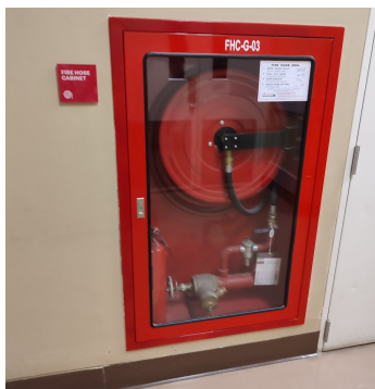
ภาพที่ 3-24 ตู้เก็บสายฉีดน้ำดับเพลิงและอุปกรณ์
