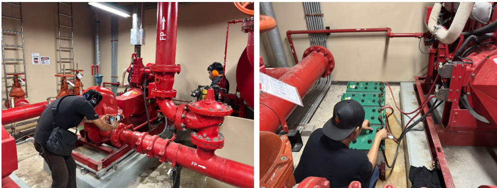
ภาพที่ 3-42 ตรวจสอบระบบ Fire Pump เป็นประจำทุกเดือน
